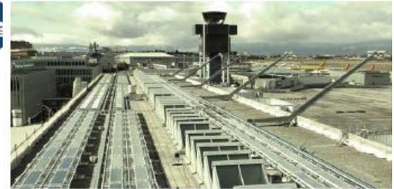
**Aile Ouest** : 1'140 m<sup>2</sup> de panneaux solaires thermiques à ultra vide (pl solaire du genre en Europe. Il permet de chauffer les bâtiments l'hiver refroidir l'été).
