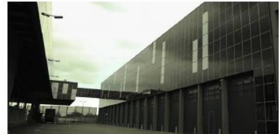
**Station de distribution de produits de dégivrage et carburant** : 4' panneaux solaires en façade et toiture
